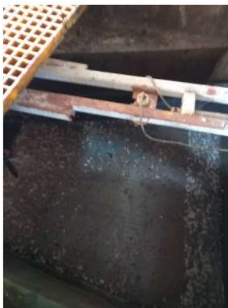
Figura 17. Verificación estado sección de medición de altura h_1 de Parshall 1.
