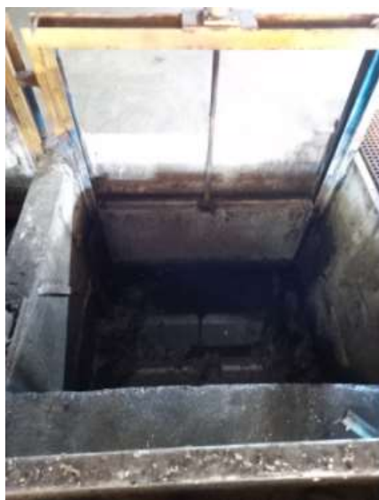
Figura 16. Verificación cierre efectivo escotilla de Parshall 1.
