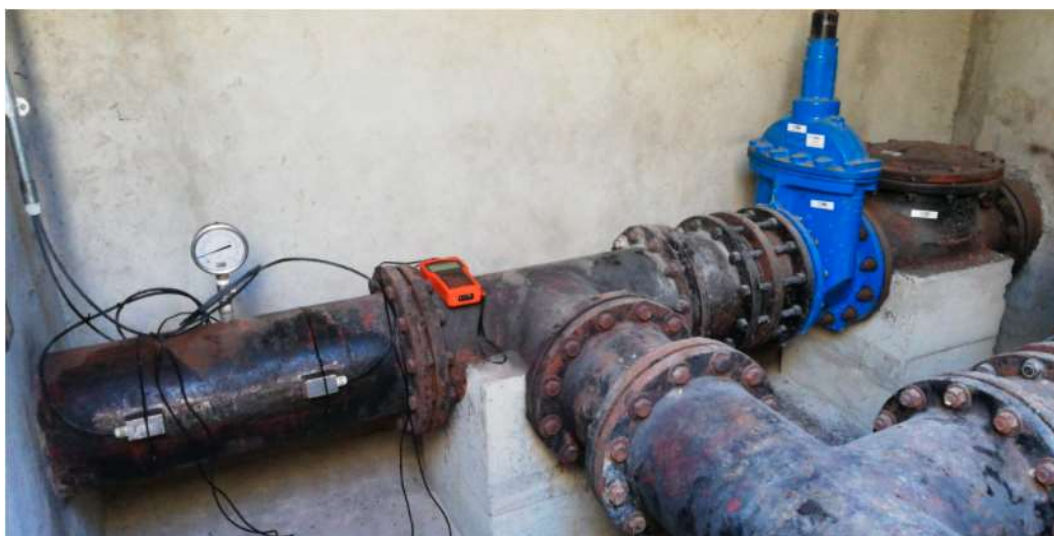
Figura 6. Flujómetro PEAS Pelluco, ubicado dentro de recinto PEAS Pelluco Puerto Montt.
