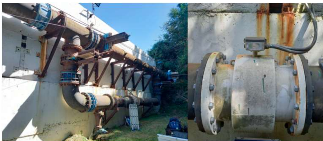
Figura 5. Flujómetro Impulsión Alerce, ubicado en deslinde Este PPTAS Puerto Montt.
